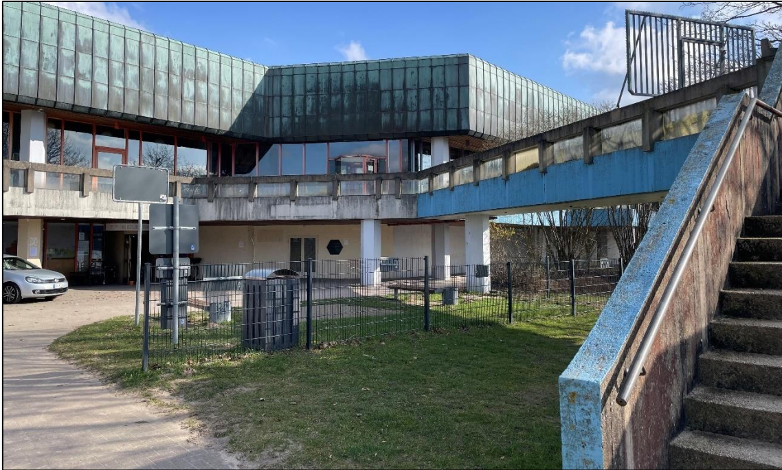
Abb. 8: Ansicht des Bestandsschwimmbades im Wegeverlauf der ehemaligen Kleinbahntrasse, Blickrichtung von der Badestelle am südlichen Plangebiet (Bild: PROKOM Stadtplaner und Ingenieure GmbH, März 2024)
