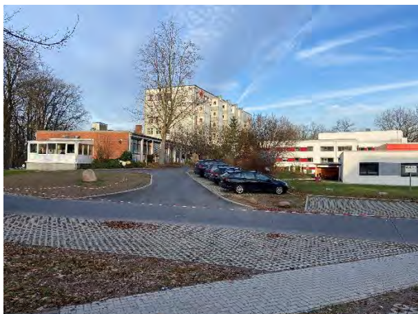
Foto 3: Straßenverkehrsflächen und Parkplätze auf dem Gelände. Intensiv gepflegte Rasenflächen sowie vereinzelte Sträucher und Ziergehölze finden sich verstreut innerhalb des Geltungsbereichs. Blickrichtung Osten.
