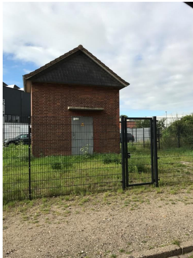
Trafostation Hafensstraße – 2 Ersatzquartiere für Hausrotschwanz
