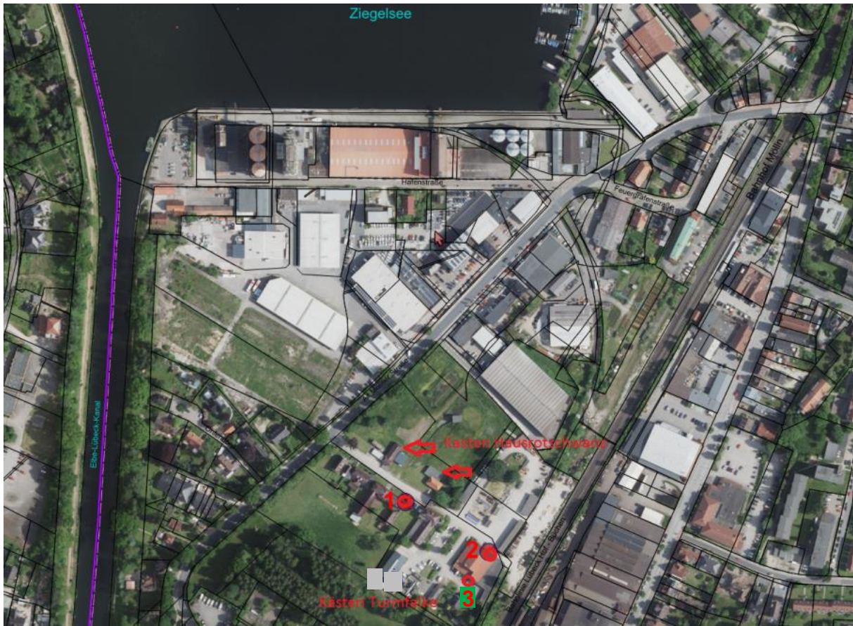
Gebäude für die Anbringung der 3 Ersatzkästen für Turmfalke sowie von Ersatzkästen für Hausrotschwanz
