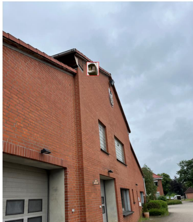
Abb.2: Turmfalkenkasten, Norden, Ausgang Osten, Montage unter Giebel 30 cm, Abstand von linken Seiten Dach 2 m, Morgensonne
