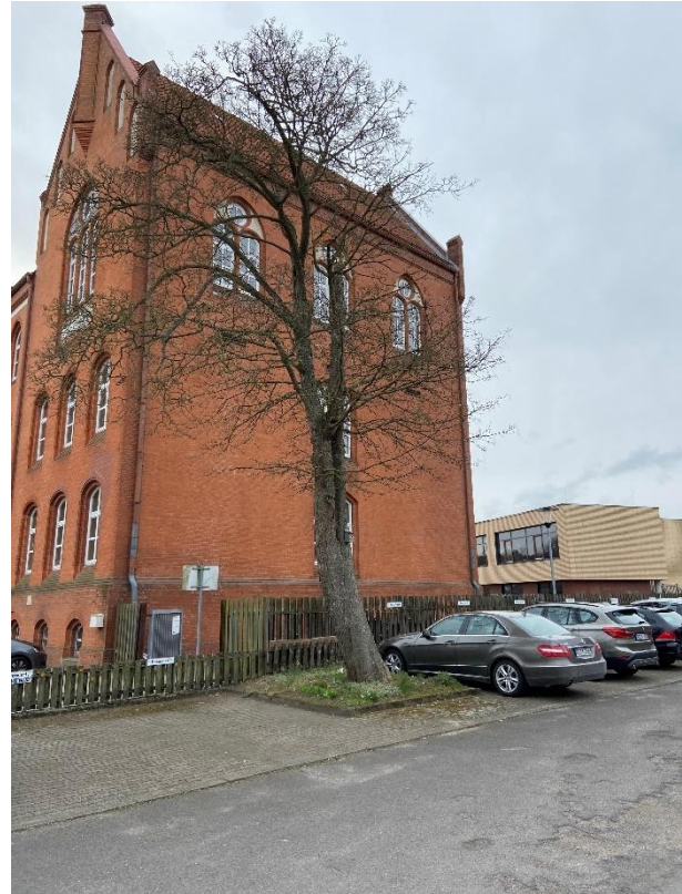
Foto 6: Westseite des ehemaligen Schulgebäudes der Ernst-Barlach-Realschule mit Höhlenbaum. Blickrichtung Südosten.
