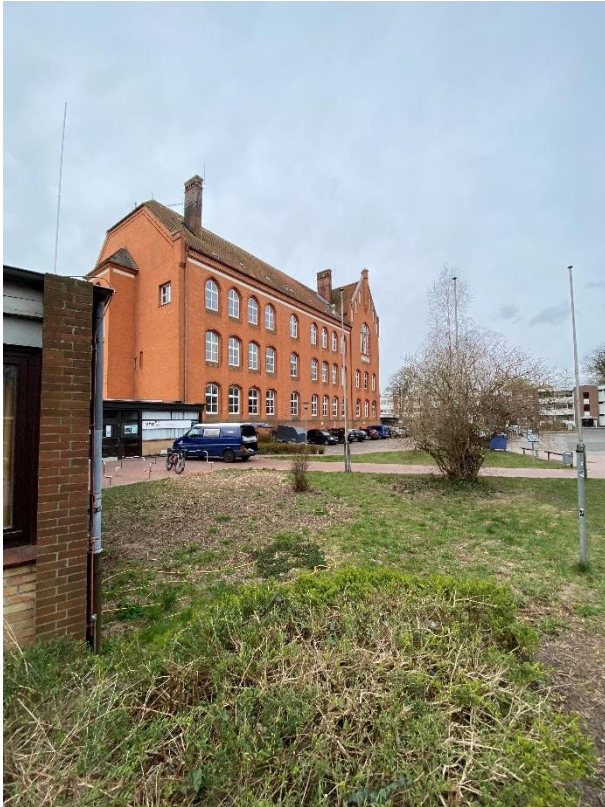
Foto 5: Ehemaliges Schulgebäude der Ernst-Barlach-Realschule. Blickrichtung Südwesten.
