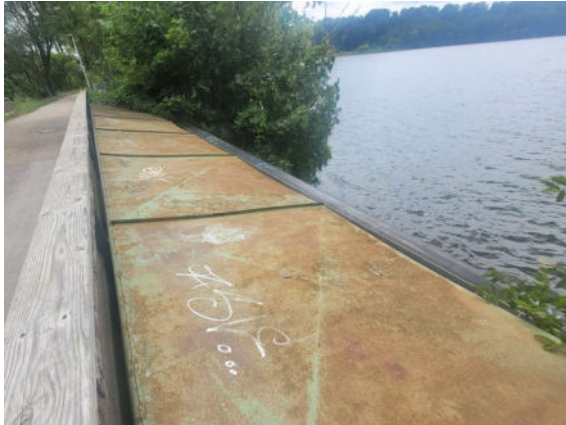
2024_KORROSIONSSCHUTZ VERWITTERT
