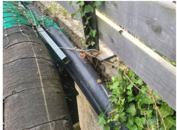
2024_PFOSTENVERANKERUNG ÜBERSTEHEND
