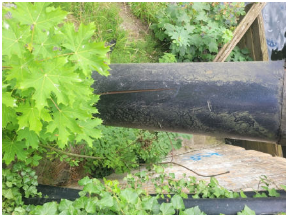
2024_SCHADHAFTE UMMMANTELUNG
