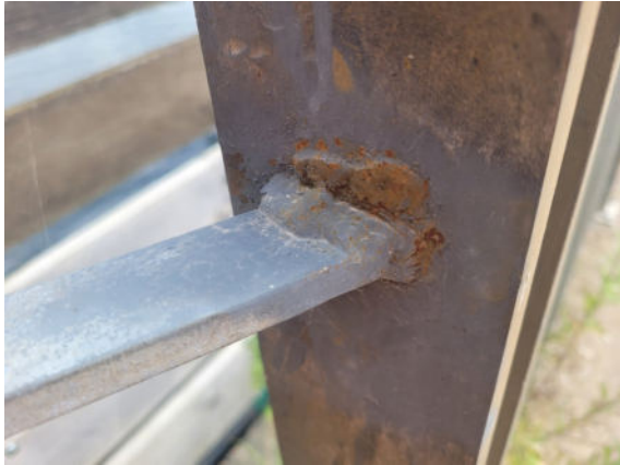
2024_GELÄNDER KORROSION
