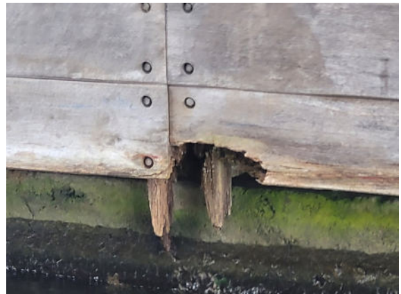
2024_ANPRALLSCHUTZ VERWITTERT
