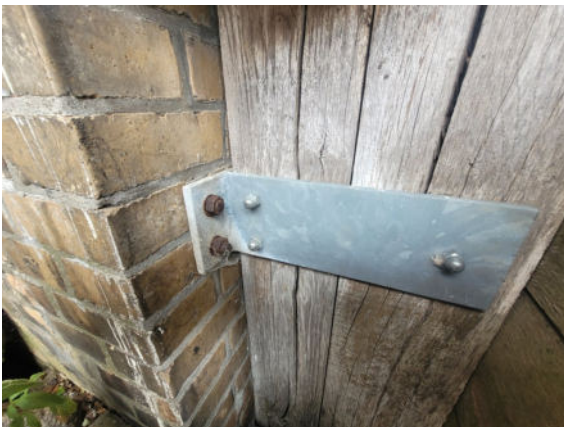
2024_BEFESTIGUNG ANPRALLSCHUTZ
