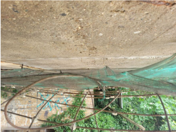
2024_BETON ABGEPLATZT
