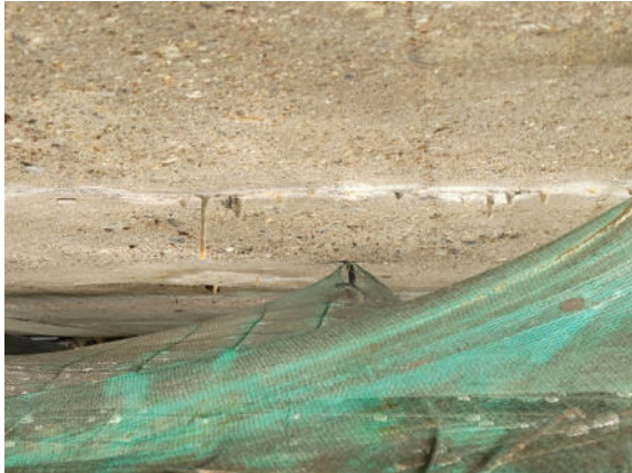
2024_QUERRISS MIT AUSSINTERUNGEN
