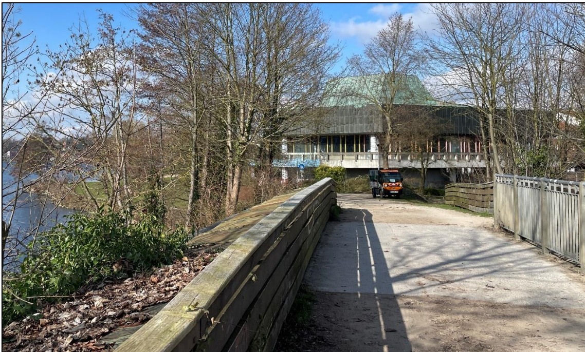
Abb. 13: Ansicht des Bestandsschwimmbades im Wegeverlauf der ehemaligen Kleinbahntrasse, Blickrichtung vom Kleinbahndamm
