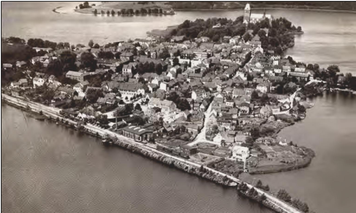
Abb. 20: Luftbild historischer Bestand südlicher Inselrand mit Kleinbahndamm und Bahnhof (Quelle: Kreismuseum Ratzeburg)
