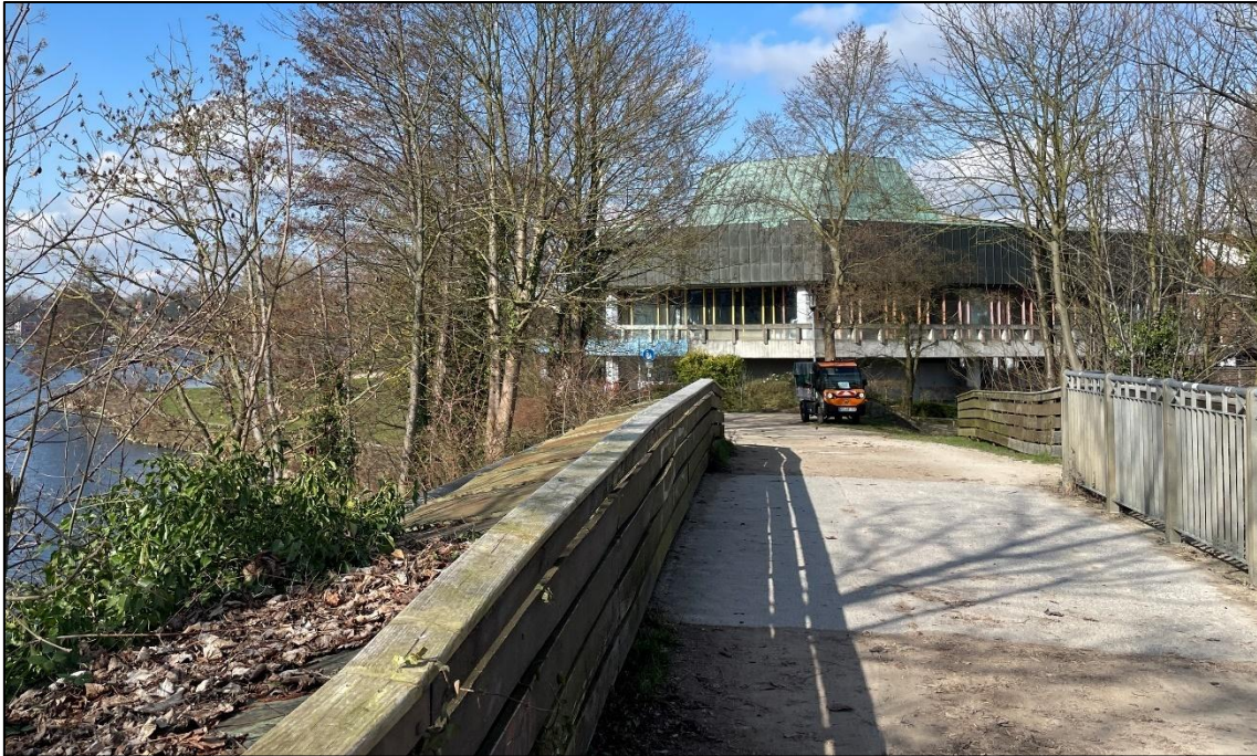
Abb. 21: Ansicht des Bestandsschwimmbades im Wegeverlauf der ehemaligen Kleinbahntrasse, Blickrichtung vom Kleinbahndamm
