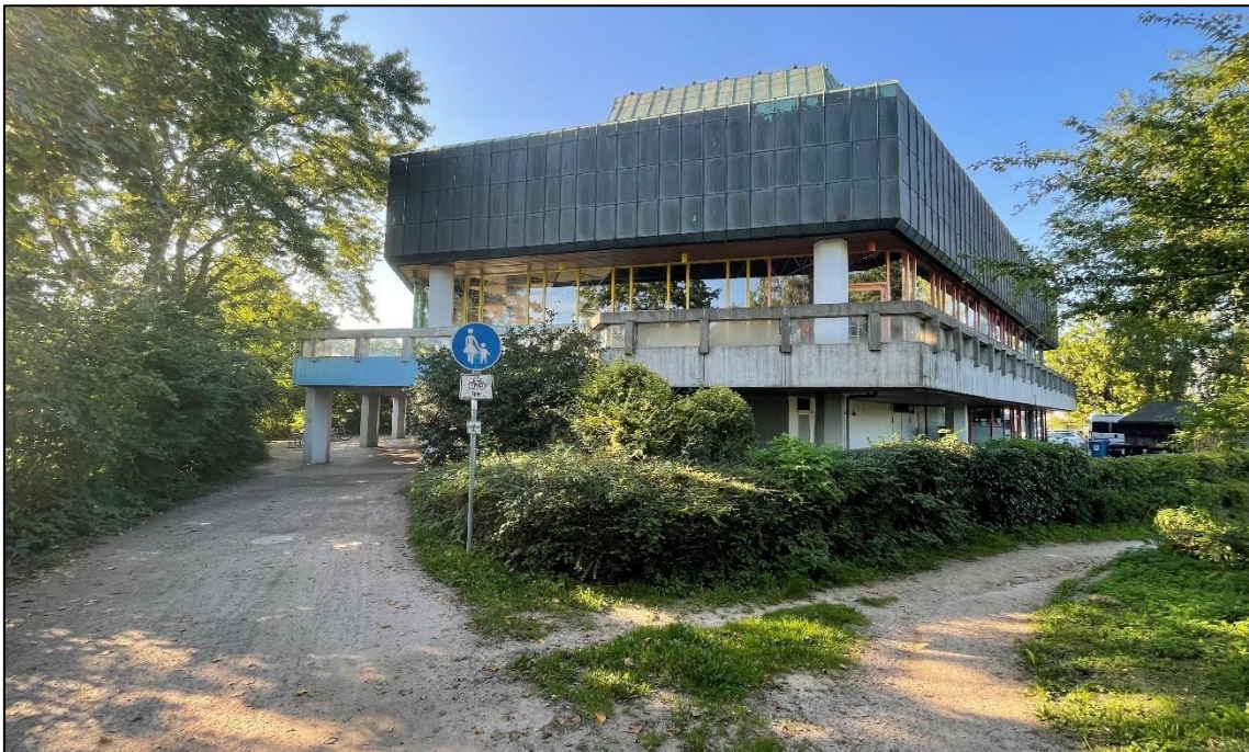
Abb. 7: Ansicht des Bestandsschwimmbades im Wegeverlauf der ehemaligen Kleinbahntrasse, Blickrichtung vom Kleinbahndamm (Bild: PROKOM Stadtplaner und Ingenieure GmbH, September 2021)
