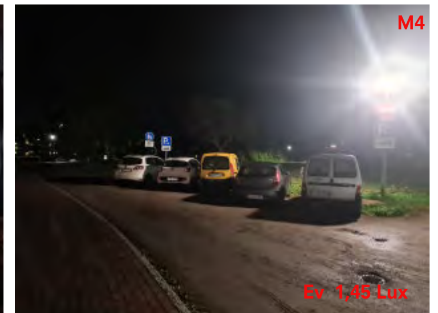
Blickrichtung Ost Lichtanteil durch Mastleuchten
