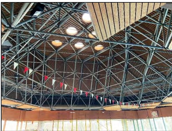
Foto 13: Dachkuppel im Südosten des Aqua Siwa.
