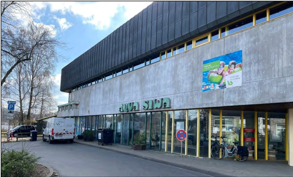
Abb. 6: Ansicht des Eingangsbereiches des Bestandsschwimmbades (Bild: PROKOM Stadtplaner und Ingenieure GmbH, März 2024)
