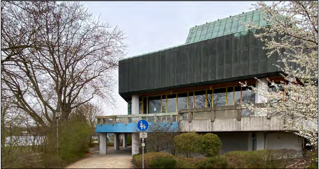
Foto 9: Baumbestand am bestehenden Schwimmbad
