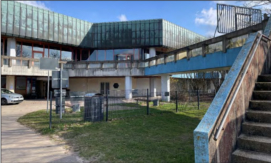
Abb. 8: Ansicht des Bestandsschwimmbades im Wegeverlauf der ehemaligen Kleinbahntrasse, Blickrichtung von der Badestelle am südlichen Plangebiet (Bild: PROKOM Stadtplaner und Ingenieure GmbH, März 2024)
