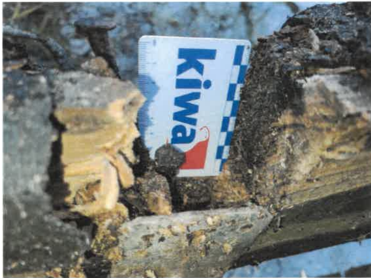
2024_LÄNGSTRÄGER VERFAULT
