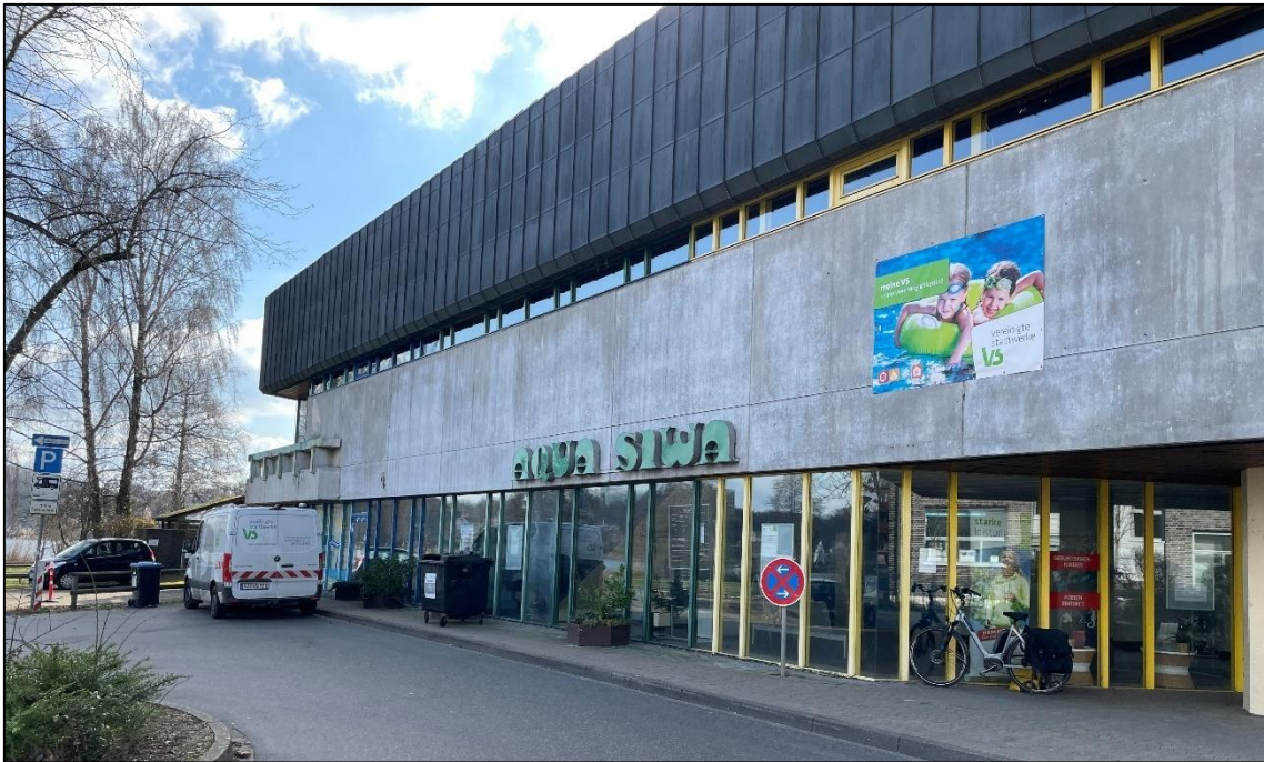
Abb. 6: Ansicht des Eingangsbereiches des Bestandsschwimmbades (Bild: PROKOM Stadtplaner und Ingenieure GmbH, März 2024)
