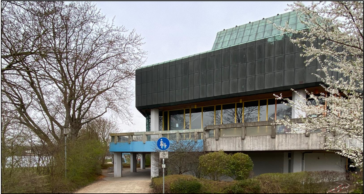
Foto 9: Baumbestand am bestehenden Schwimmbad
