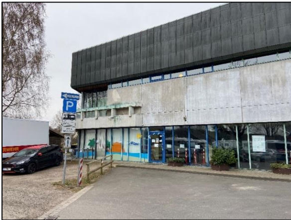
Foto 1: Nordöstliche Außenansicht des Aqua Siwa. Blickrichtung Süden. Angrenzend Parkplatz. Hoher Versiegelungsgrad.
