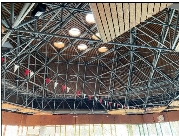
Foto 13: Dachkuppel im Südosten des Aqua Siwa.
