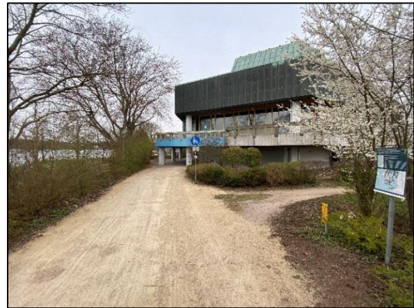
Foto 2: Südöstliche Außenansicht vom Kleinbahndamm. Blickrichtung Nordwest. Älterer Baumbestand in Ufernähe zum Kuchensee.
