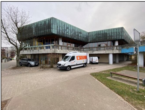
Foto 3: Südwestliche Außenansicht. Blickrichtung Nordosten. Hoher Versiegelungsgrad. Älterer Einzelbaum am Aqua Siwa sowie Rasenflächen an der angrenzenden Badestelle.
