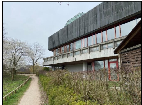
Foto 4: Östliche Außenansicht. Blickrichtung Süden. Hecken und Ziergehölze sowie ältere Einzelbäume am Weg.
