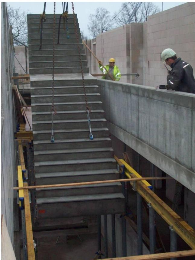
Die Haupttreppenanlage im Forum wird montiert
