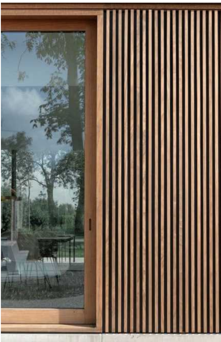
Holzfassade, EG hell
