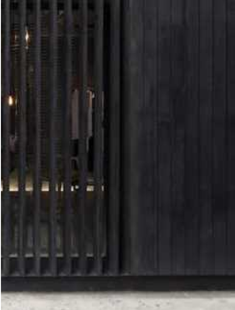
Holzfassade, OG dunkel
