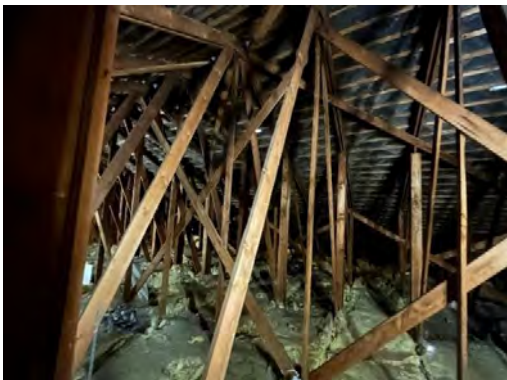
Dachstuhl über Clubraum mit abgehängter Decke
