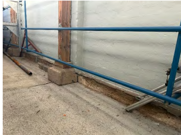
schlanke Hallenstützen flach gegründet; sichtbarer „Betonfraß“ der Bankette
