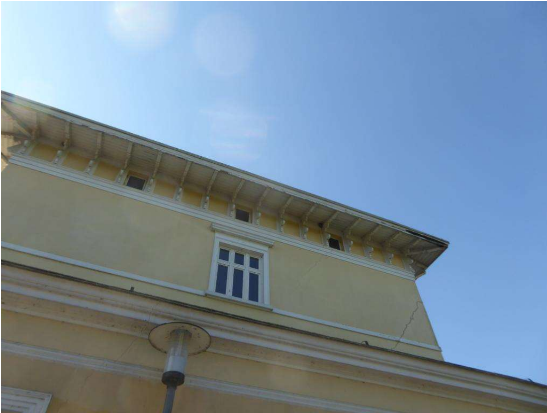
Abbildung 9 Mehlschwalbennester unter dem Dachvorstand des Bahnhofgebäudes
