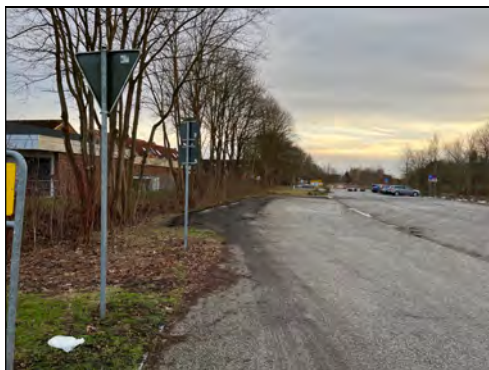
Abbildung 5: Blick auf den Plangeltungsbereich vom Bahnhofsvorplatz aus mit Zufahrt zum Lidl-Markt vorne links sowie einer provisorischen Verbreiterung zugunsten einer Wendemöglichkeit für Busse.
