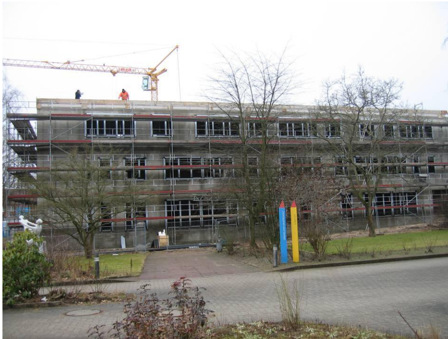
Die Ostfassade ist komplett mit Fenstern bestückt (29.02.2012)
