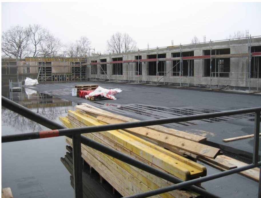
Dachabdichtung über 1. OG
