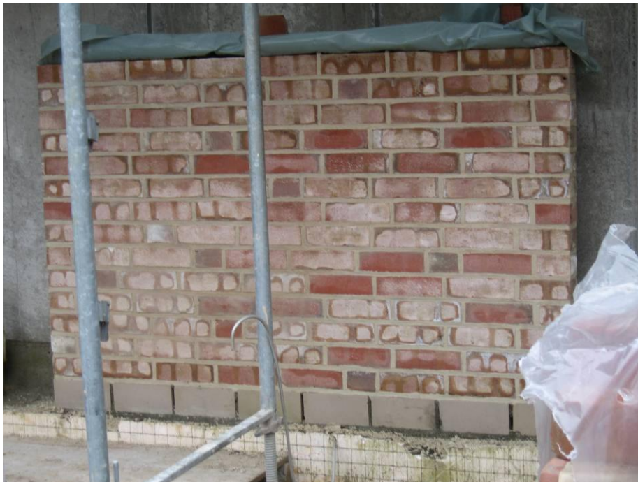
Musterfläche Verblendmauerwerk
