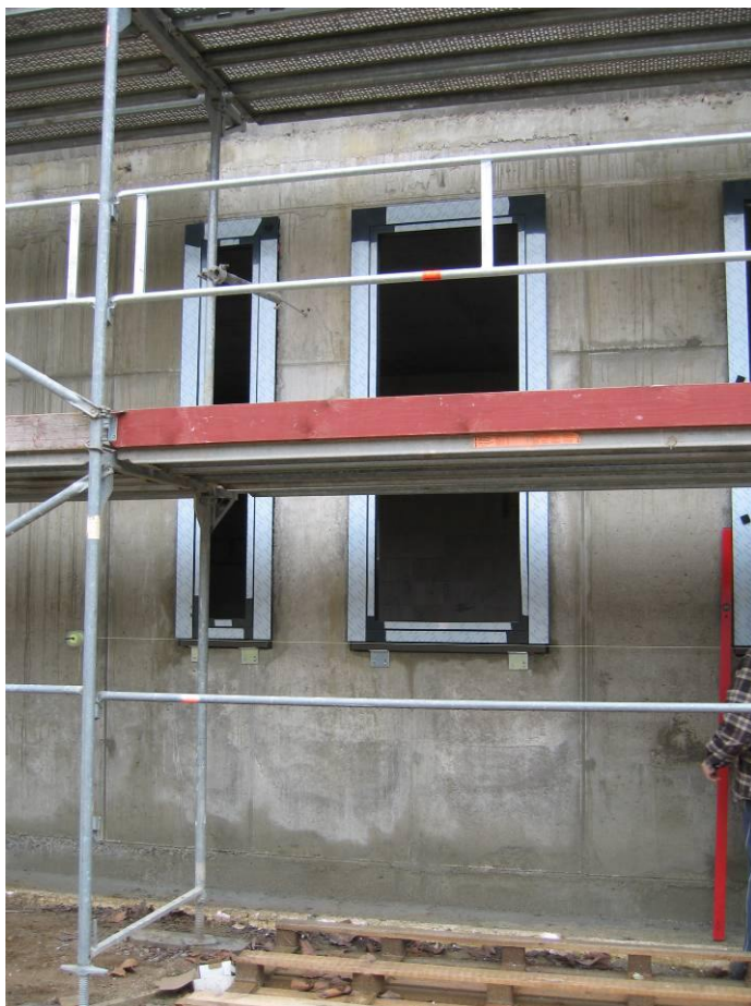
Erste Fenster in der Ostfassade sind montiert (22.02.2012)
