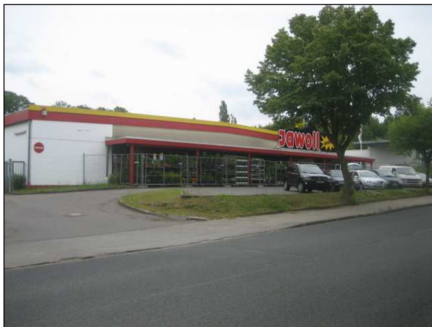
Abb. 2 Ansicht des Sonderpostenmarktes von der Heinrich-Hertz-Straße aus
