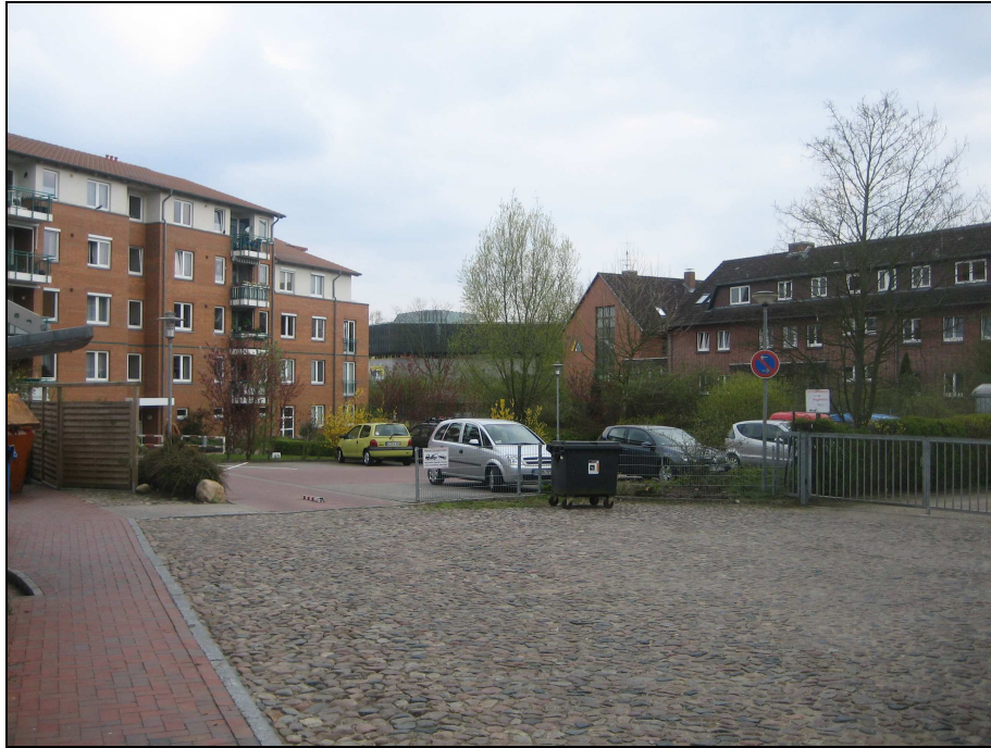
Abbildung 3. Jugendherberge von Norden mit Wohnbebauung an der Fischerstraße
